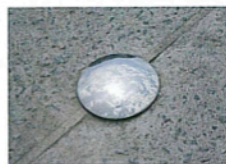
▲ Des clous inox servent à matérialiser les aires de stationnement et les passages piétons.
