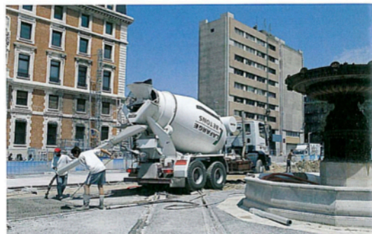
▲ Coulage du béton à l'avancement sur la place de la Joliette.
