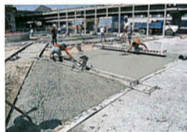
▲ Les travaux sont réalisés à raison de bandes de 200-250 m 2 par jour.
