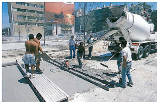
▲ Mise en œuvre, vibration et pervivance du béton fibré désactivé.
